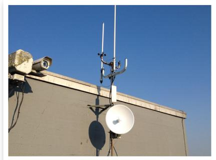
HAMNET-Einstiegsantenne und Linkantenne nach DBØDY Lengerich.
